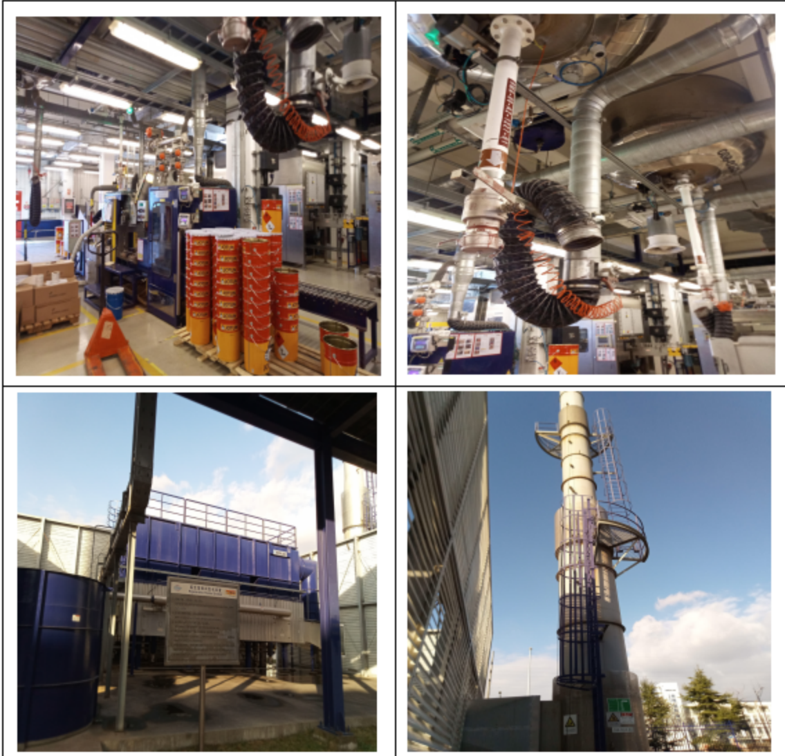
图 4-2 集气措施+蓄热式焚烧炉+P1 排气筒图
